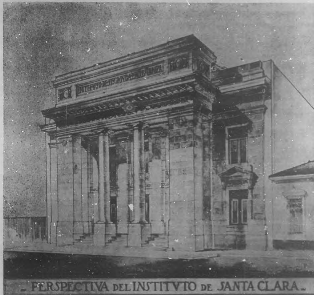
Vista exterior del edificio que para Instituto Provincial, se construye actualmente, en Santa Clara. Ley del senador Berenguer.
